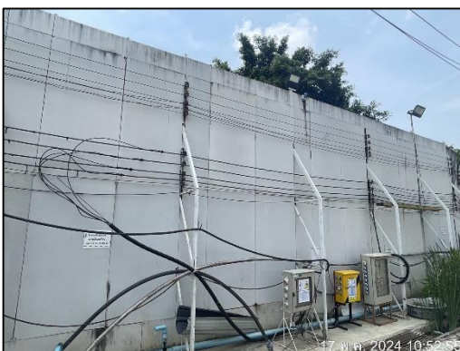
ภาพที่ 3 กำแพงกันเสียงชนิด Bloxteg 2 Tuff Series
