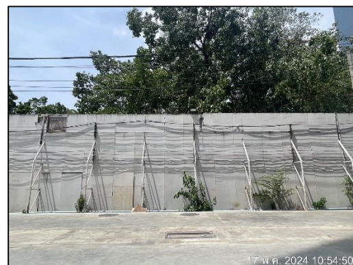
ภาพที่ 3 กำแพงกันเสียงชนิด Bloxteg 2 Tuff Series
